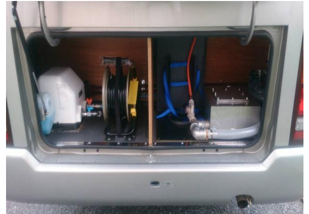
■後部ガスボンベ置場
